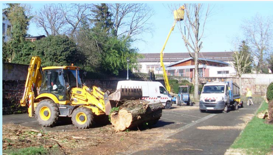
Parking des Remparts
