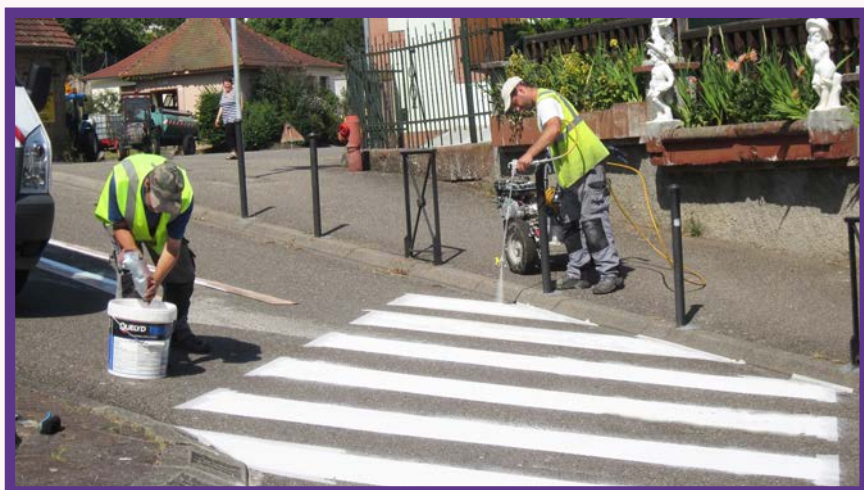
Marquage routier, rue du Canal
