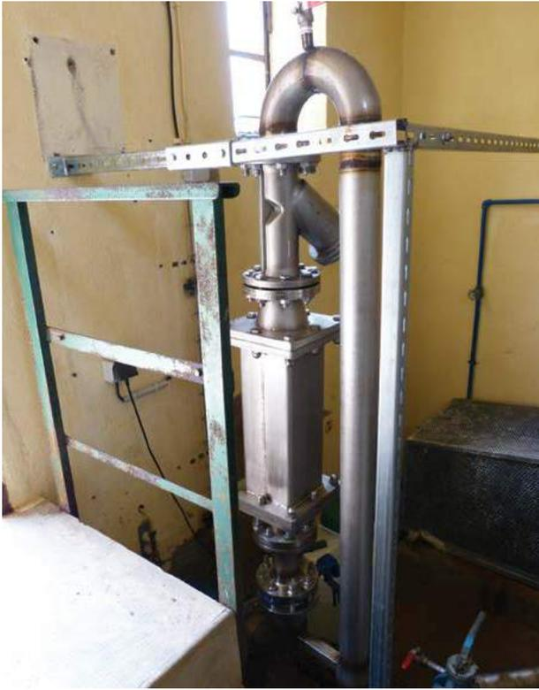
Système de traitement magnétique du calcaire installé au forage de Griesbach-le-Bastberg
