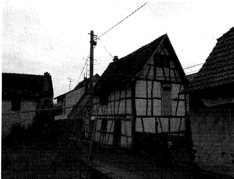
Maison située 13 rue du Fossé
