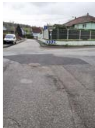
Les travaux réalisés suite à l'affaissement de la chaussée
