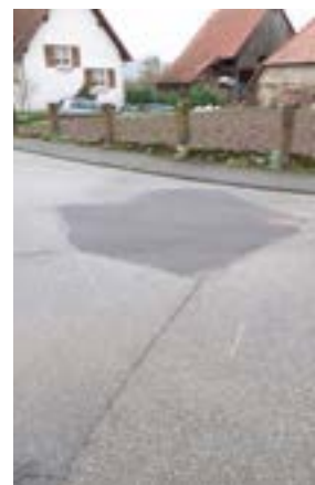
Les travaux réalisés suite à l'affaissement de la chaussée
